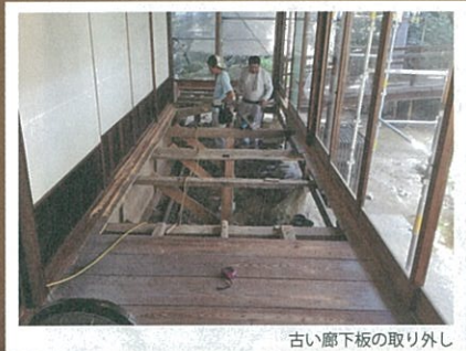
古い廊下板の取り外し
