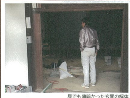
昼でも薄暗かった玄関の解体
