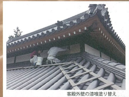
客殿外壁の漆喰塗り替え
